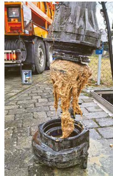
Einsatz in Spremberg: Die in der Toilette entsorgten Feuchttücher und andere Abfälle haben sich zu einem undurchdringlichen Klumpen vermischt, der aufwendig entfernt werden musste. Das ist nicht nur unappetitlich und verworfen, sondern verursacht enorme Kosten. Foto: SWAZ
